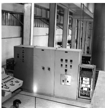
Cercetări ale unor grupuri hidroenergetice submersibile
