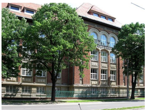
Clădirea Principală a Școlii Politehnice din Timișoara (1946)
